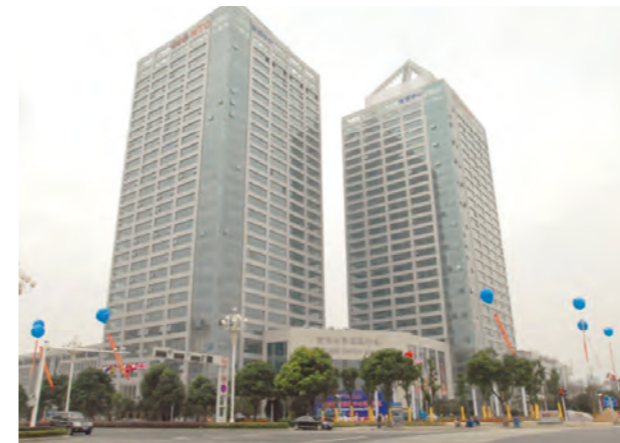
WORLD TRADE CENTER – Changzhou China 496 unidades exteriores, sistemas bomba de calor (Potencia instalada 14 MW)
