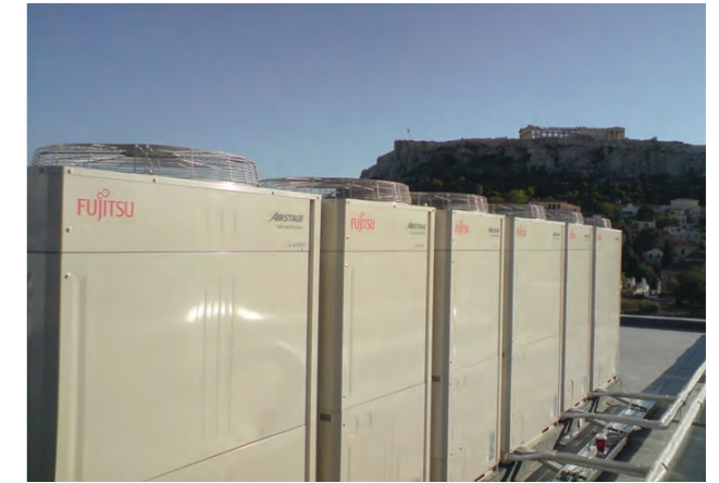
FNAC PLAKA – Atenas Grecia 6 sistemas bomba de calor AIRSTAGE V-II (Potencia instalada 360 kW)
