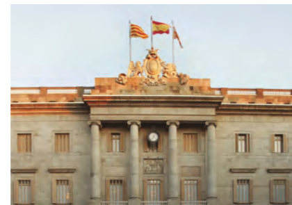
OFICINAS AYTO. DE BARCELONA 4 sistemas con recuperación de calor AIRSTAGE VR-II (Potencia instalada 203 kW)
